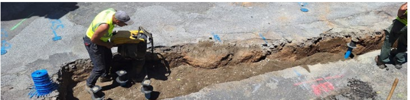
Les travaux ont démarré Place Gabriel Péri
